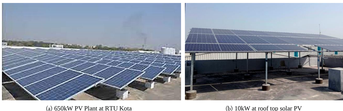
Fig. 5. Roof top Solar PV in Kota City
